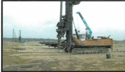
ภาพถ่ายขณะปฏิบัติงานเจาะเสาเข็มเพื่อสร้างโรงไฟฟ้าจะนะ จังหวัดสงขลา
