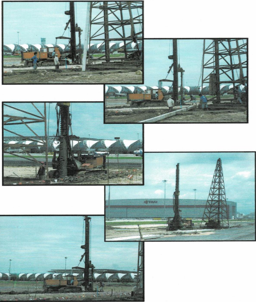
ภาพถ่ายขณะปฏิบัติงานเจาะเสาเข็มเพื่อสร้างสนามบินแห่งชาติสุวรรณภูมิ
